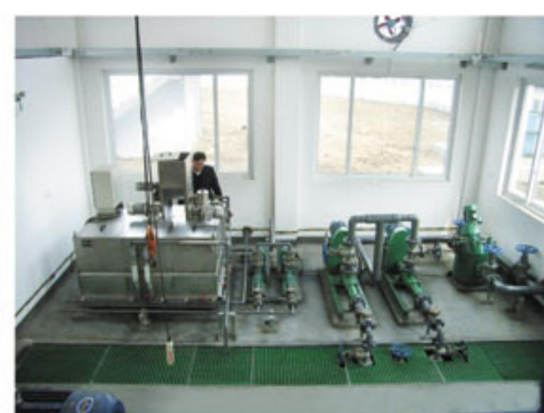
于2005年选用了我公司4套LW355×1600-N污泥离心脱水成套装置（机械差速），分别安装于上海青浦区金泽污水处理厂和西岑污水处理厂。当进料浓度2~3%时，最大处理量达到8m<sup>3</sup>/h，脱水泥饼含水75~78%。
